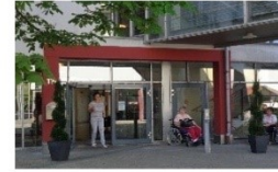
Wohn- und Begegnungszentrum Zehnthof
